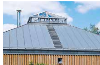
Uchwyty dla stopni lub rusztów komunikacji dachowej
