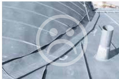
Kosz z bocznymi połączeniami na rąbek
