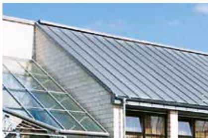
Kalenica dachu jednospadowego na listwę
