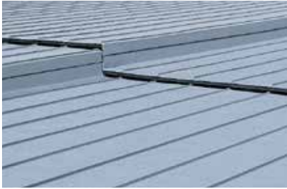
Połączenie poprzeczne: uskok z rąbkem leżącym
