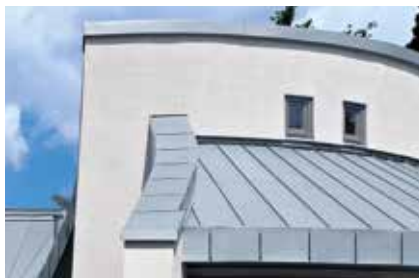
Techniki łączenia zapewniające ruch blachy
