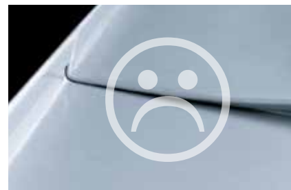
Kalenica dachu jednospadowego bez zapasu na rozszerzenie i o zbyt małym odgięciu do góry
