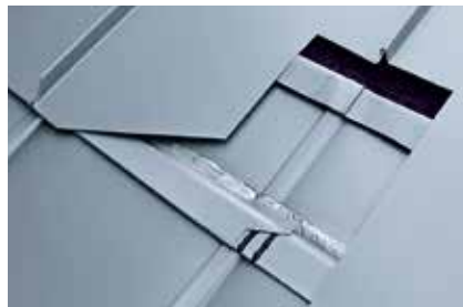
Optymalne wykonanie: dodatkowy pas wlotowany
