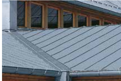
Kosz z rąbką pojedynczym oraz pasem włutowanym
