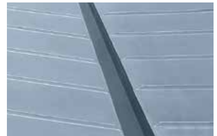
Rynna wewnętrzna skrzynkowa z wyklejaną rynną zabezpieczającą
