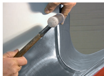
Doklepanie rąbka młotkiem plastikowym
