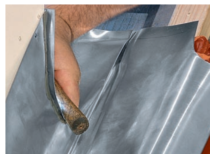
Zawijanie fartucha/kołnierza bocznego
