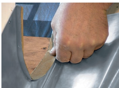
Przygotowanie połączenia klejonego
