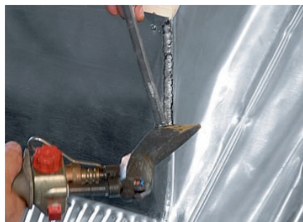
Lutowanie od strony okapu
