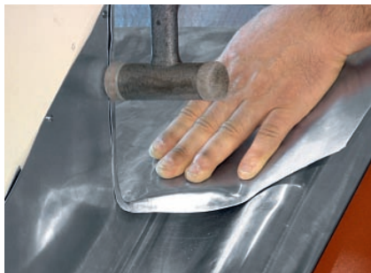
Połączenie kołnierza bocznego z fartuchem
