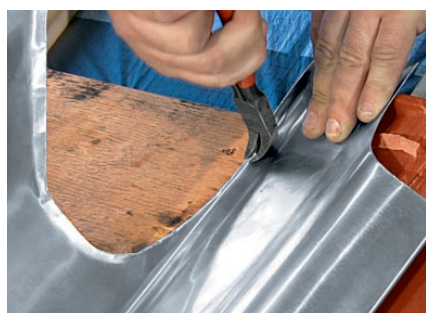
Przygotowanie rąbka kołnierza tylnego
