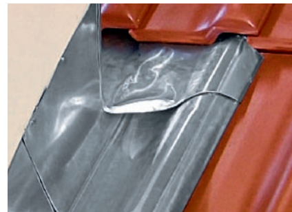
Gotowa obróbka od strony kalenicy
