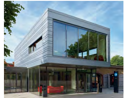
Renowacja kampusu studenckiego, Osnabrück, Niemcy
